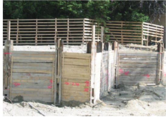
Abbildung 3: Berliner Verbau und Baumschutzzaun
